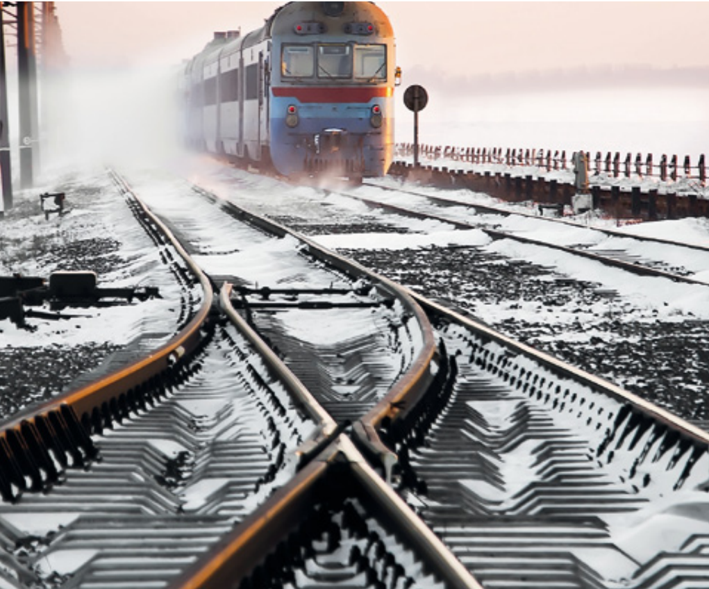
Damit die Weichen im Winter nicht einfrieren, werden sie bislang aufwendig beheizt. InfraGrid bietet die Chance, den Stromverbrauch und damit auch die Kosten für Energie deutlich zu senken.
